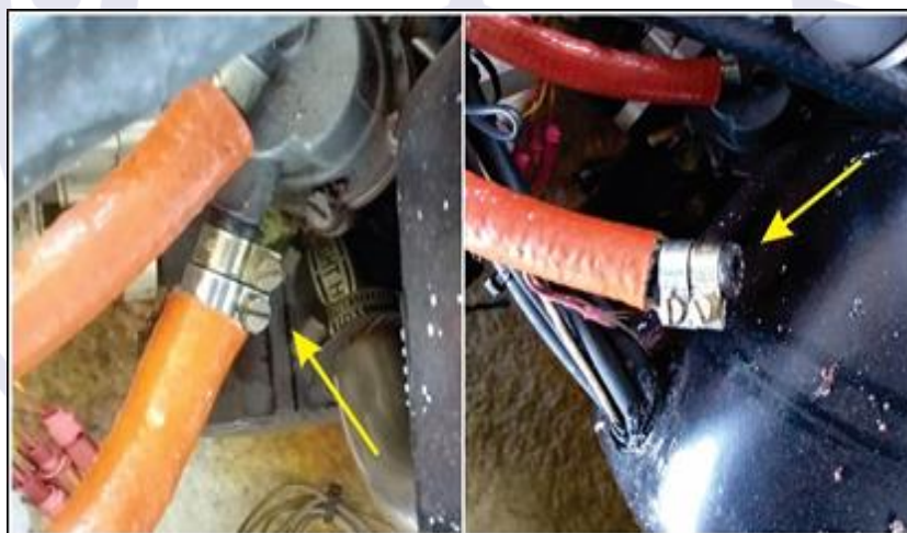
Figura 3 - Detalhe das braçadeiras da conexão de entrada de combustível para a bomba.
