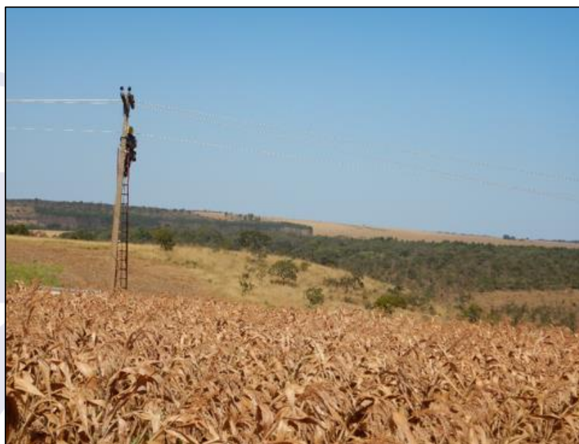
Figura 4 - Técnico realizando o reparo no cabo elétrico.
