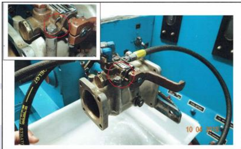
Figura 3 - Vazamento no lado da alavanca de corte de combustível.
