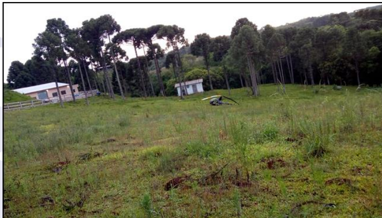
Figura 4 - Vista geral do local do acidente.
