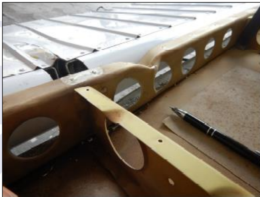
Figura 3 - Dano na longarina traseira do estabilizador horizontal esquerdo.
