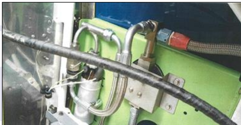
Figura 5 - Bomba elétrica de combustível automotiva instalada na aeronave.
