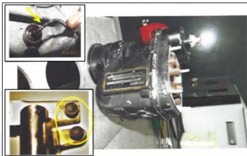
Figura 3 - Vista geral do magneto direito do motor direito. Os destaques mostram o cabo do capacitor danificado e os contatos do platinado queimados.
