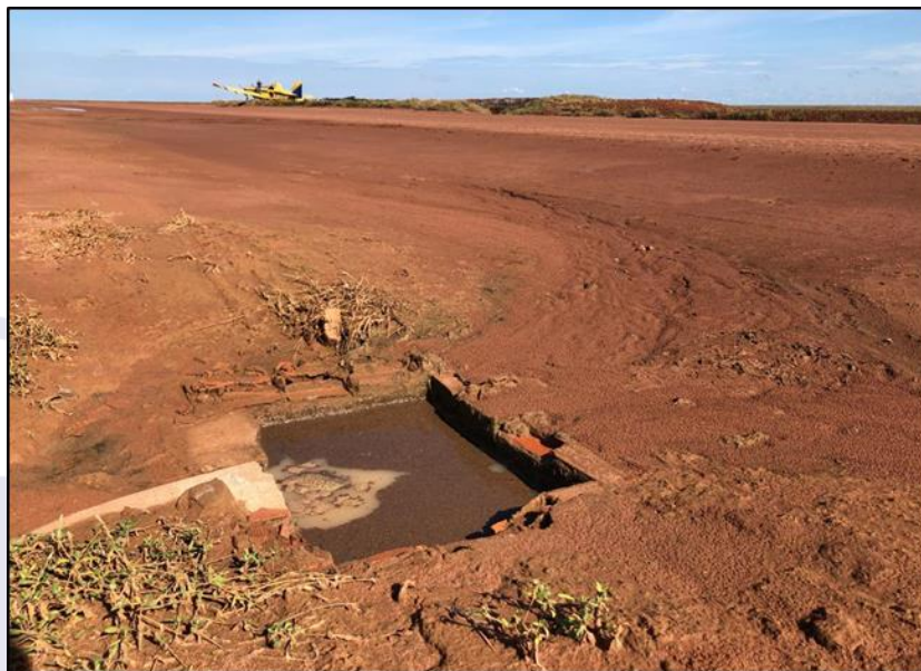
Figura 3 - Sistema de drenagem pluvial da pista (sumidouro).
