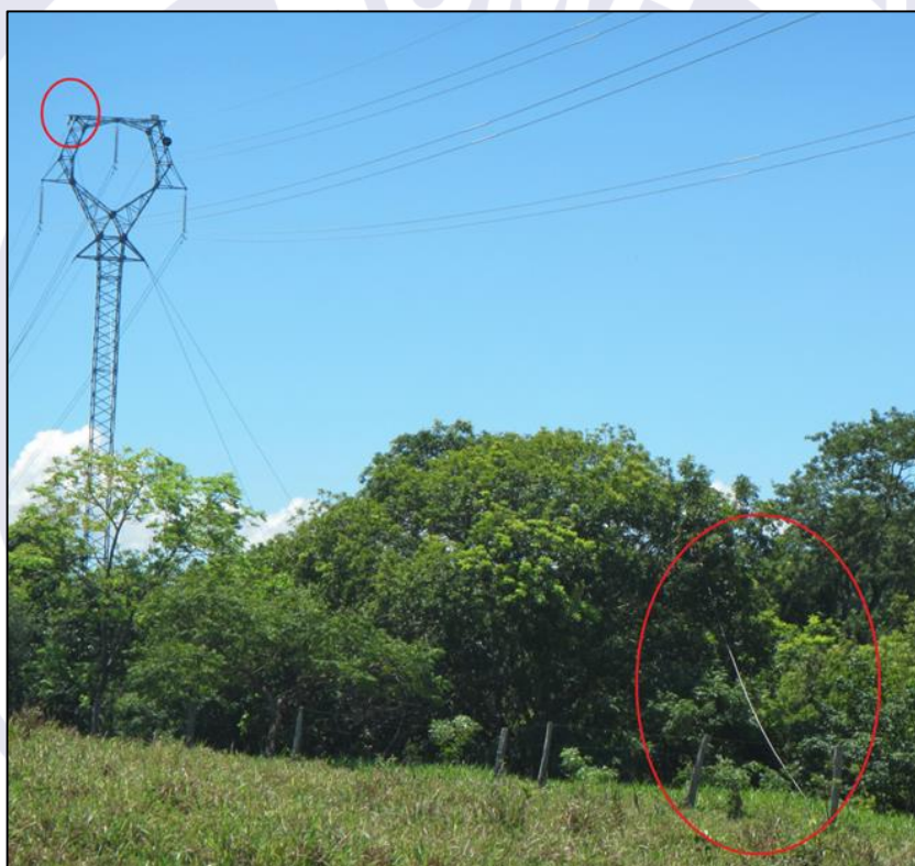
Figura 4 - Ausência do segundo fio guia e fio sobre a árvore.
