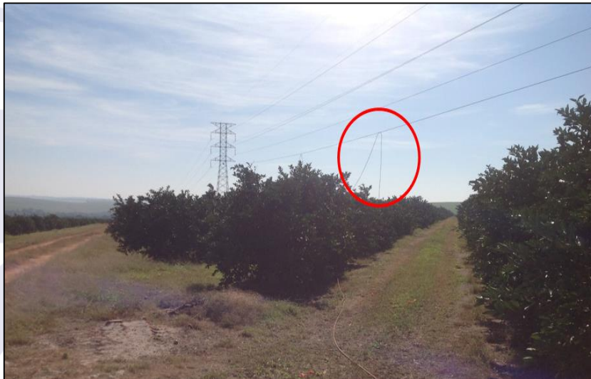
Figura 3 - Rede elétrica de alta tensão.
