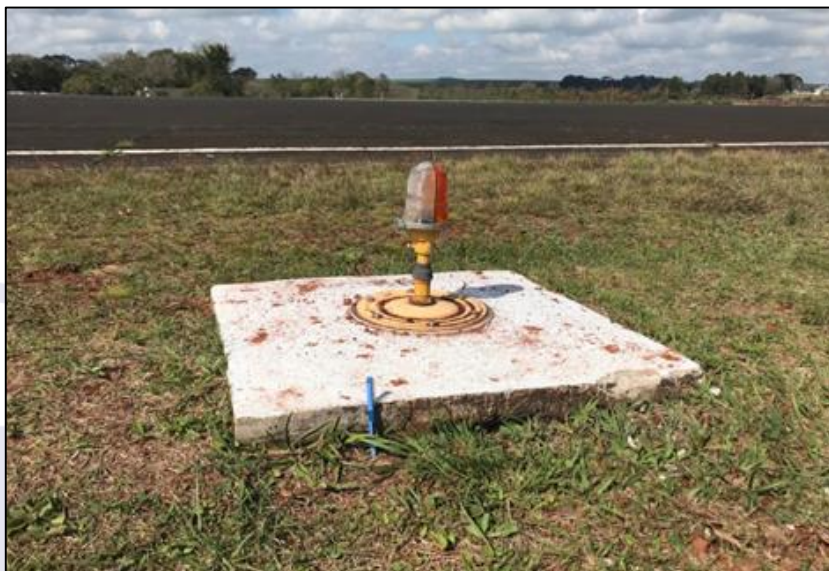
Figura 3 - Estrutura de concreto contra a qual o trem de pouso do PP-GNY colidiu.
